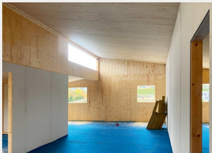
CLT-Dach mit Sandwichdacheindeckung ▲
