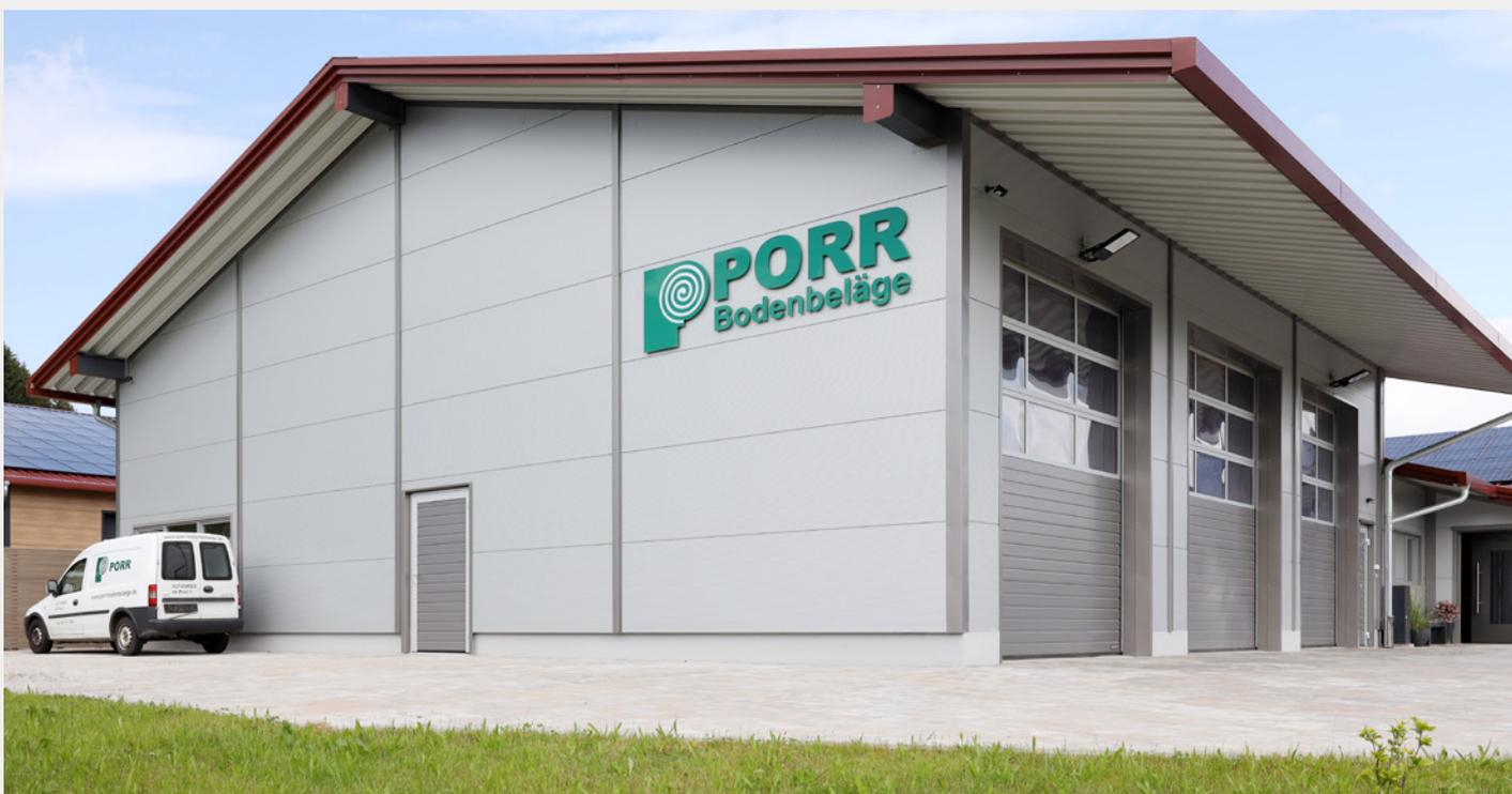
Höhenversetztes Dach und große Vordächer ohne teure Unterkonstruktion ▲
