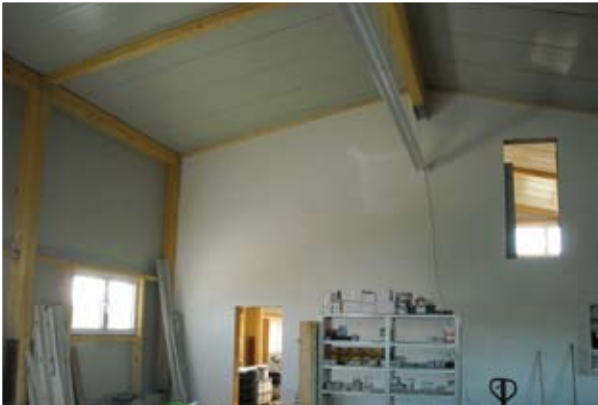
Mehrzweckhalle mit Sandwichelementen
