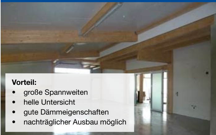
Parallele Binderkonstruktion mit eingelegten Dämmstoffplatten
