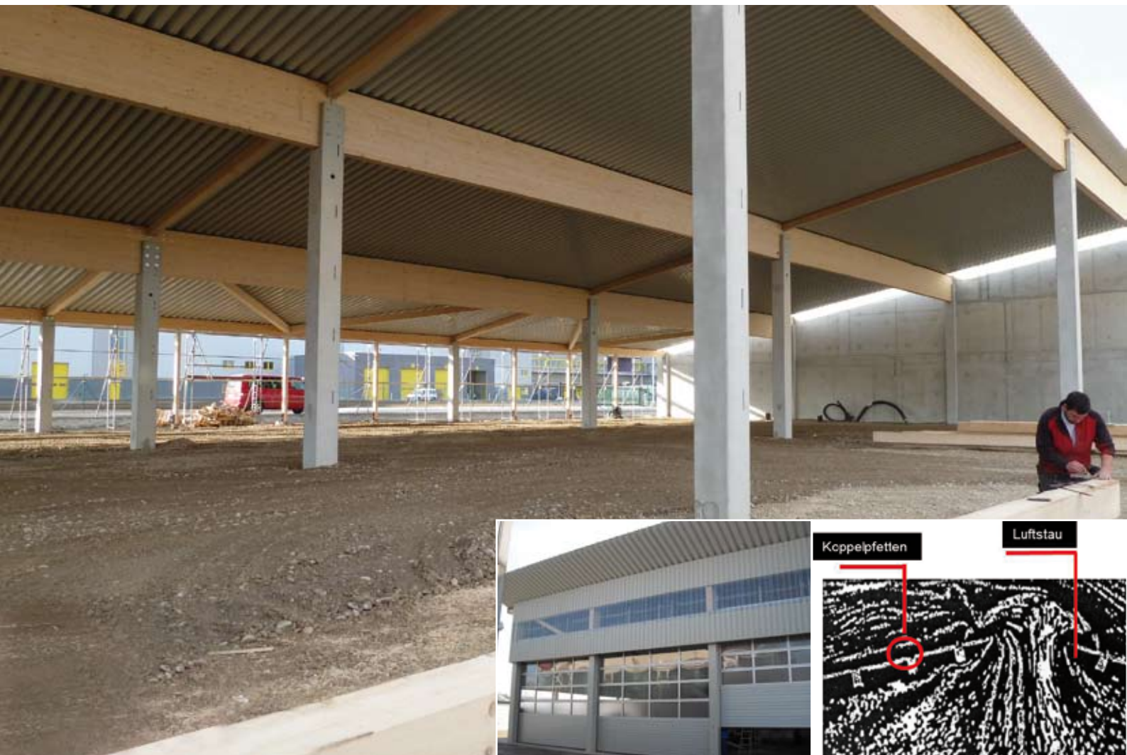
Pfettenkonstruktion mit weitgespanntem Trapezblechdach
