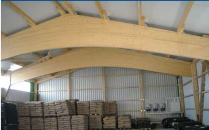
Parallele Binderkonstruktion mit eingelegten Dämmstoffplatten
