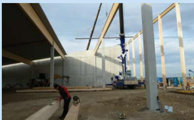
Pfettenkonstruktion auf Stahlbetonstützen
