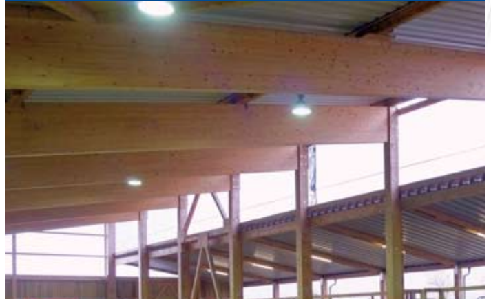
Binderkonstruktion mit geringer Überhöhung auf Betonstützen
