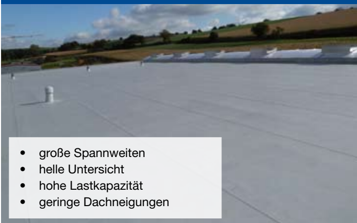
Aufdachdämmung mit Dämmstoffplatten und Foliendach Tragschale Trapezblech
