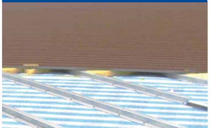
Aufdachdämmung Wasserführende Schicht = Trapezblech
