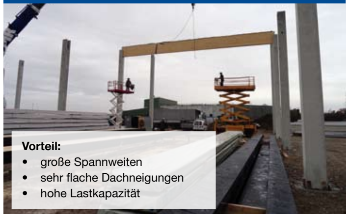
Binderkonstruktion mit geringer Überhöhung auf Betonstützen
