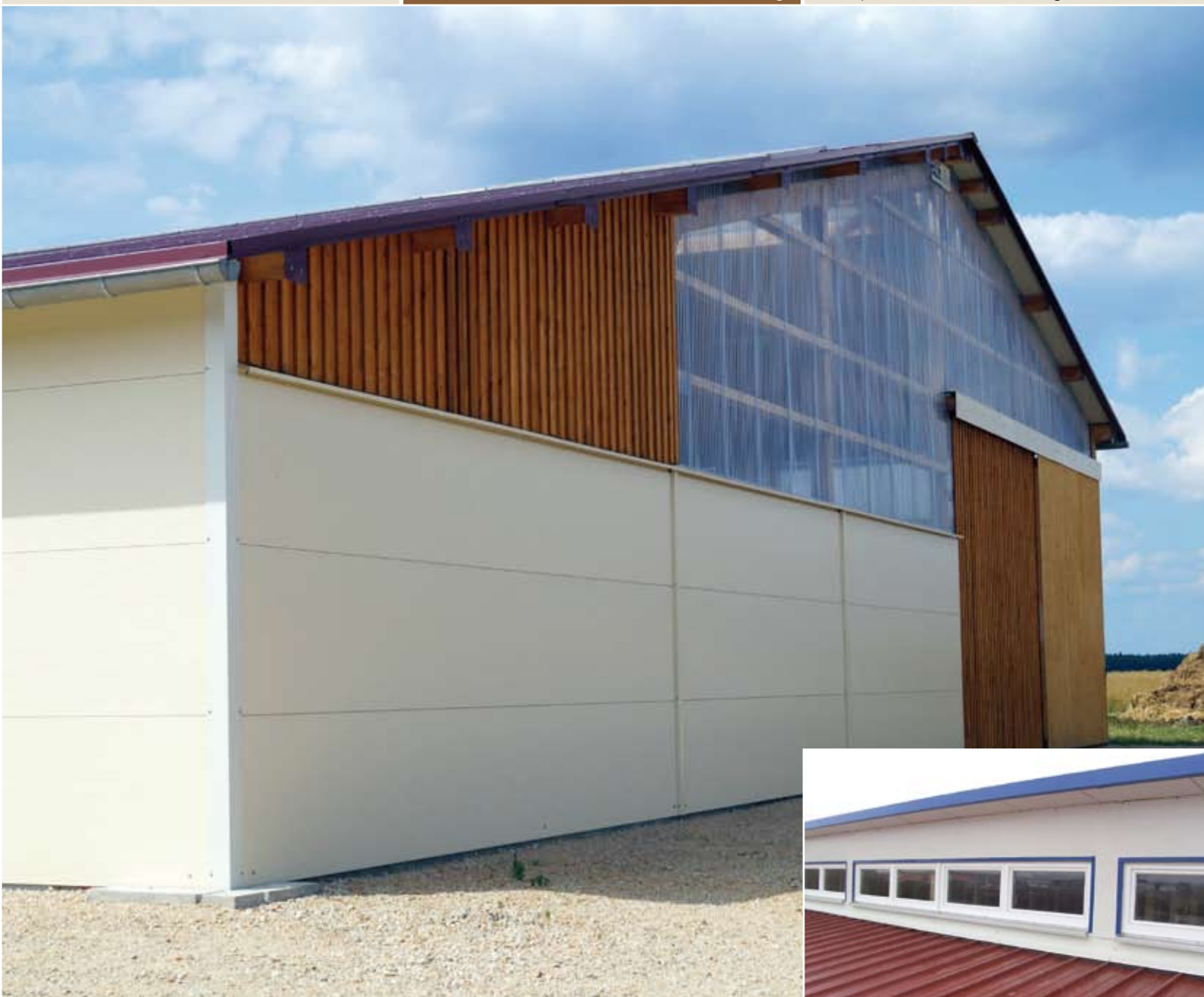
Sandwichwand Verglasung mit Lichtplatten
