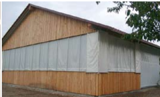
Curtain mit Folie - variable Öffnung, 100 % winddicht und trotzdem lichtdurchlässig
