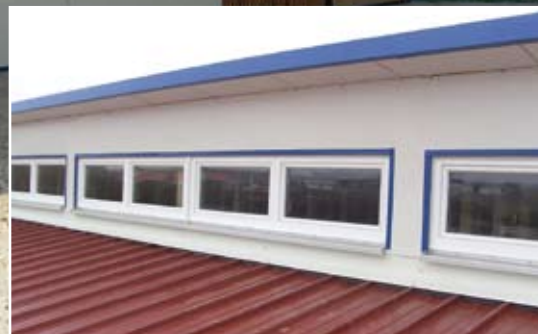
Oberlicht im höhenversetzten Dach
