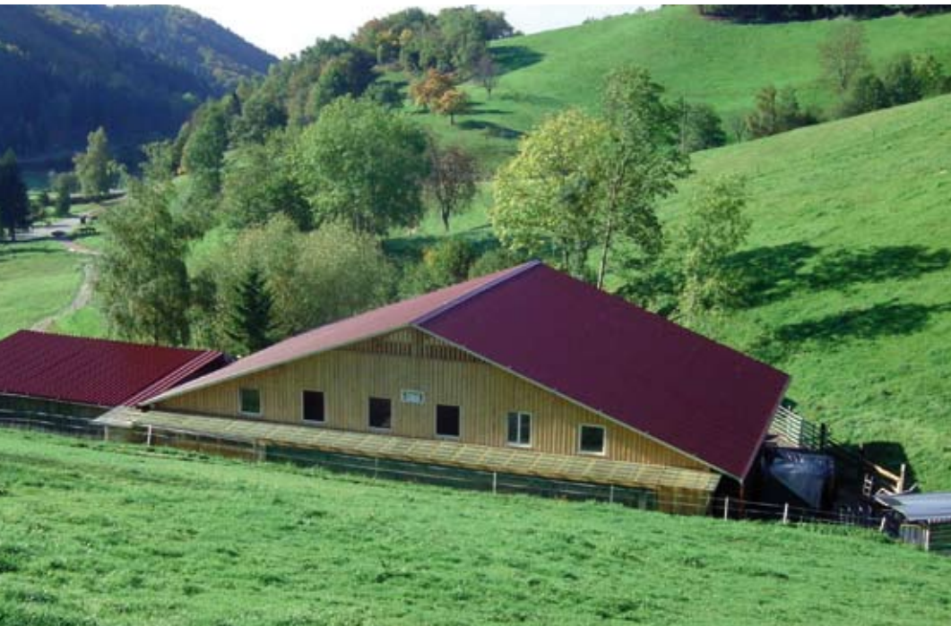
Bodendeckelschalung mit Spaceboard im Giebelspitz
