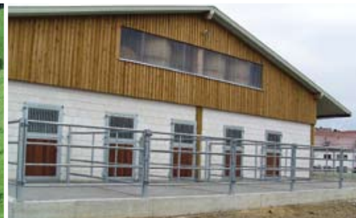
Kalksandsteinmauerwerk mit Boden- deckelschalung am Giebel und Lichtband
