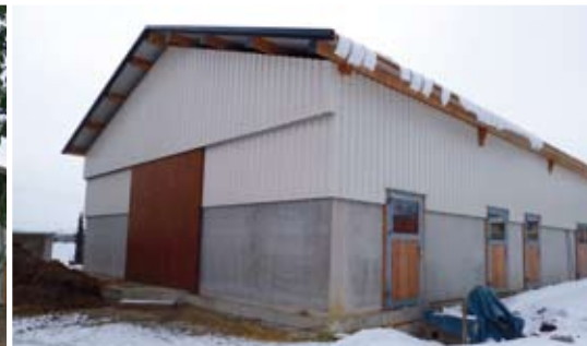
Betonwand 2 m hoch, darüber Trapezblechwandverkleidung
